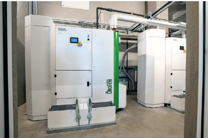
Um auch im gewerblichen Bereich den Umstieg von fossilen Energieträgern auf erneuerbare Wärme zu erleichtern, hat ÖkoFEN mit dem Pellematic Condens XL eine Pellets-Brennwertheizung mit bis zu 520 kW entwickelt.
