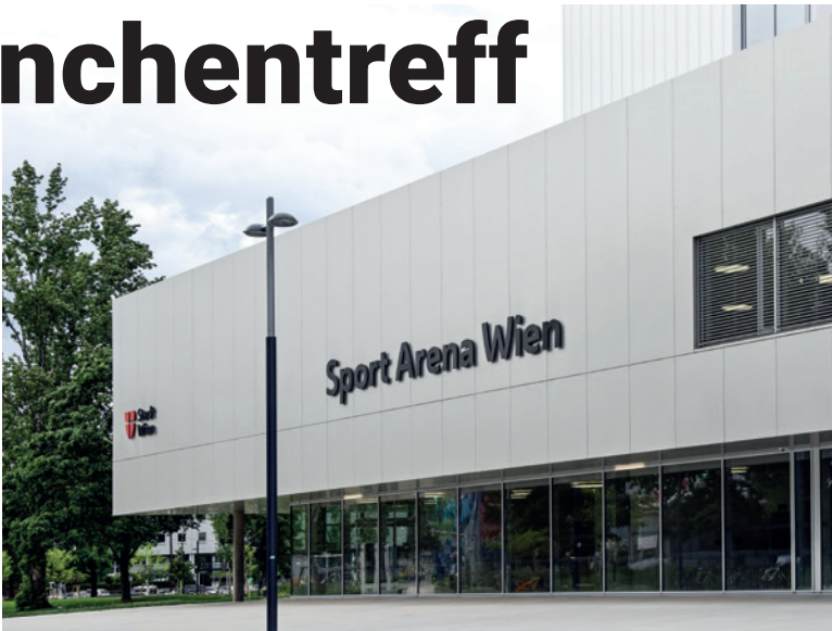
Die neue Sport Arena Wien ist mit Technik von TROX ausgestattet, die man an diesem Abend bei Haustechnik-Führungen auch erkunden konnte.
